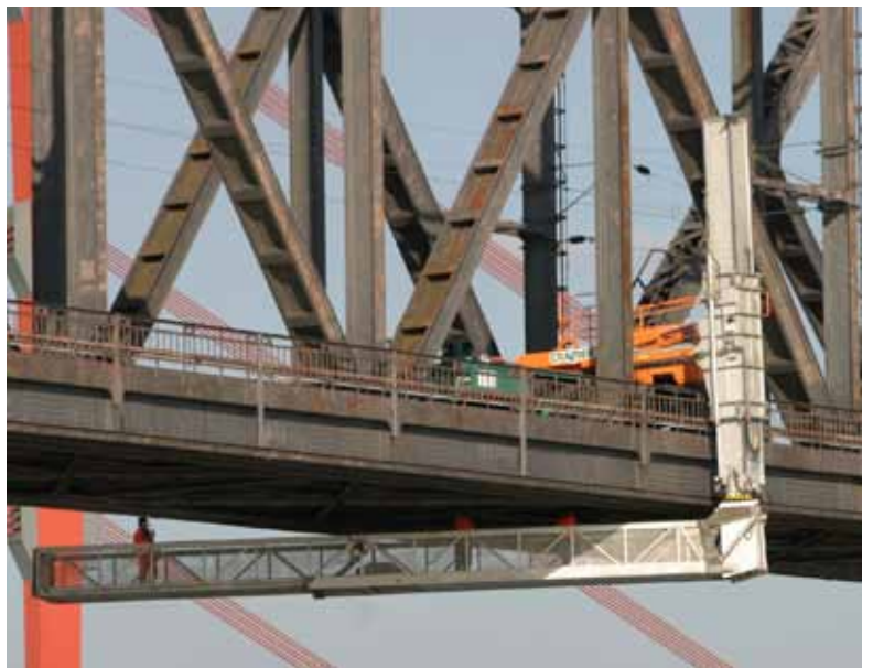
Arbeiten unter erschwerten Bedingungen
