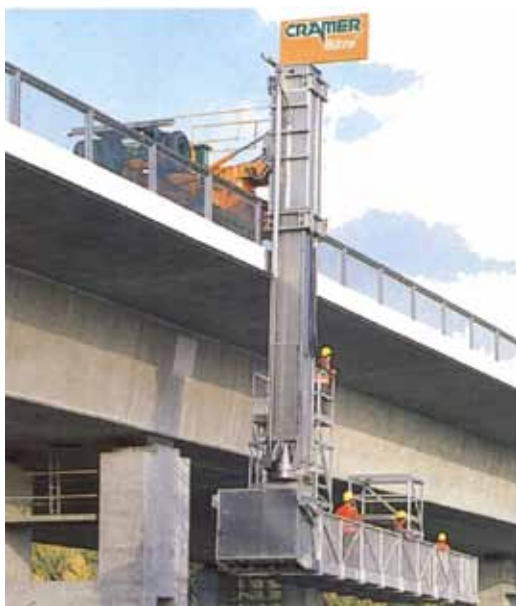
Vorbefahrt am Pfeiler
