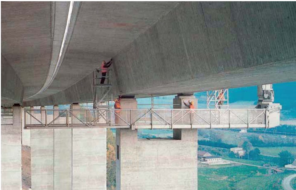
Optimale Arbeitsbedingungen für Bauwerksprüfingenieure und Helfer
