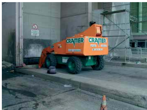
Arbeiten in einem Schacht der Müllverbrennungsanlage Köln
