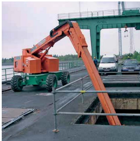
Einsatz zu Prüfarbeiten im Pumpspeicherwerk Gestacht
