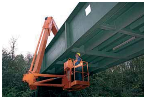
Prüfung von Gasleitungen unter einer Brücke
