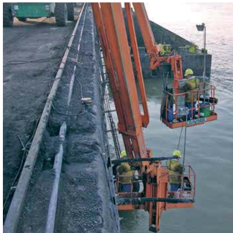
Montagearbeiten an einer Kaimauer im Werk Bayer Leverkusen
