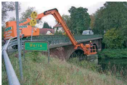
Montage von Kabeln unter der Brückenkappe
