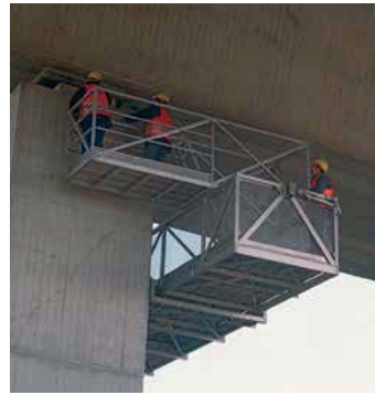
Quergerüst für Lagerprüfung
