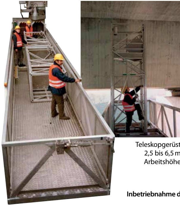
Quergerüst für Lagerprüfung
