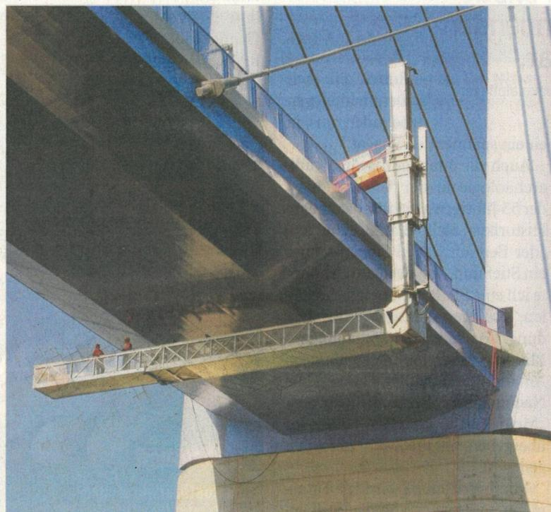
Eine selbstfahrende Teleskoparbeitsbühne im Einsatz an der neuen Lenne-talbrücke.
